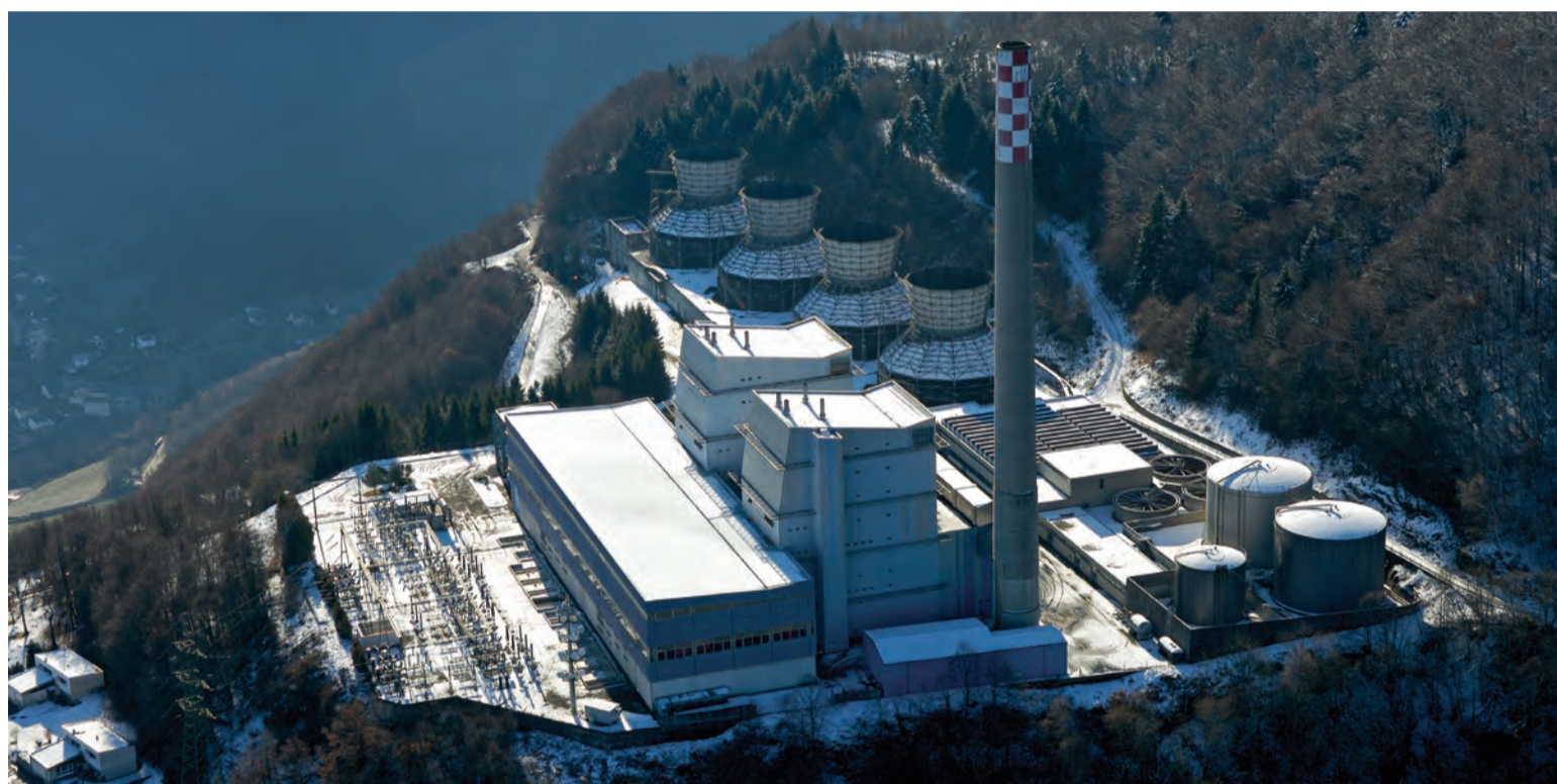
La construction de la future centrale de Chavalon pourrait commencer en 2011.
